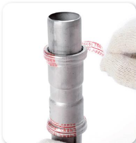
圧着完了後、フィルムを除去する。
